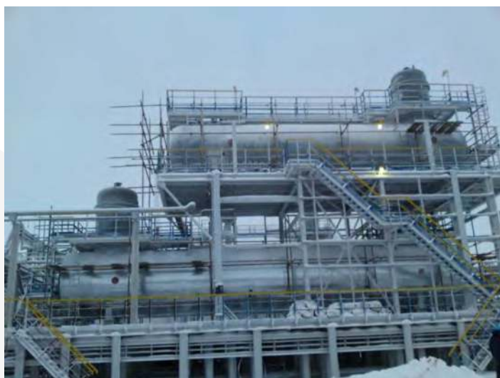
Установка Merichem в Нарьянмаре, ООО "Нарьянмарнефтегаз"
