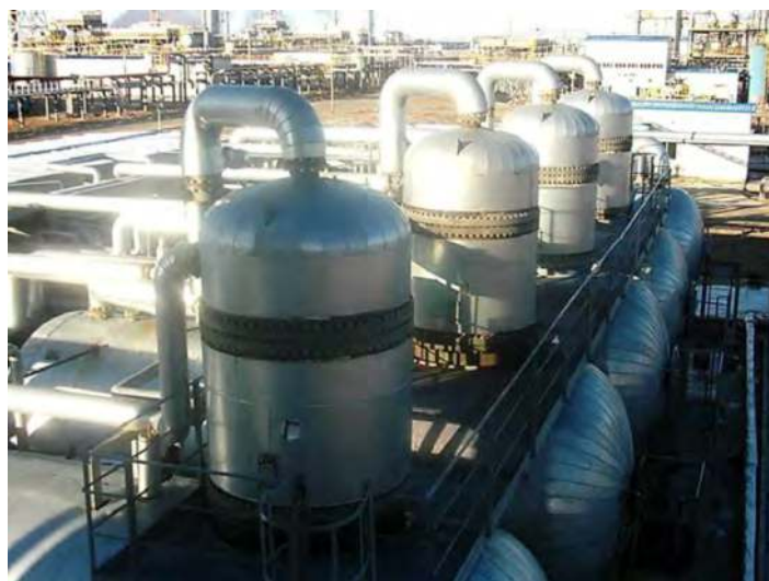
Установка Merichem на НПЗ "Жанажол", СНПС-АКТОБЕ
